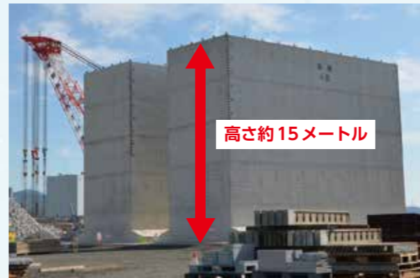
▲白くて大きな物体の正体 耐震強化岸壁の本体部分=ケーソン
