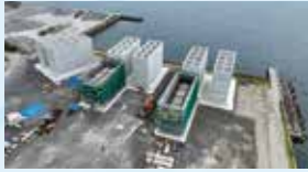
▲上空から見たケーソン
