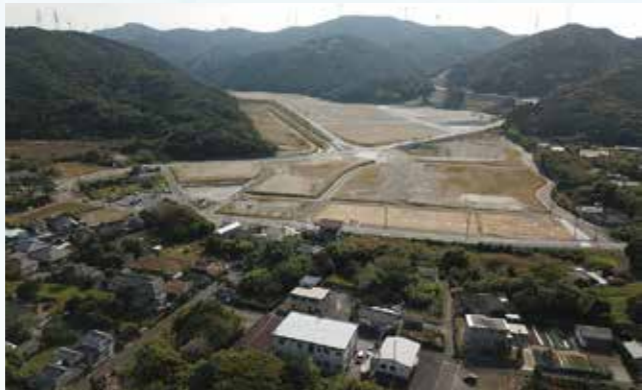
▲川内港久見崎みらいゾーン
