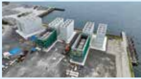
▲上空から見たケーソン
