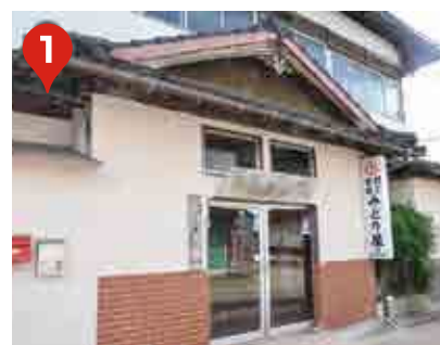
▲割烹旅館みどり屋 大正時代建築の木造3階建てです。
