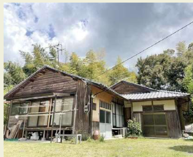
▲改修を行った空き家
