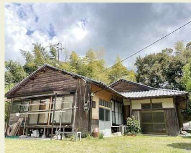
▲改修を行った空き家
