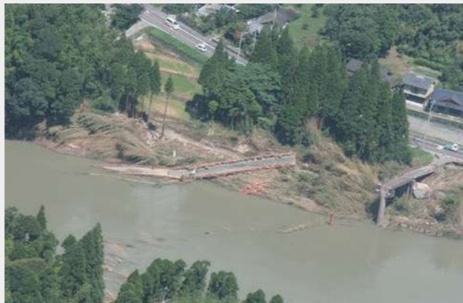
▲平成18年7月29日の久住橋の様子
