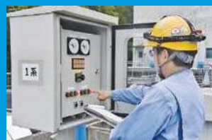
▲浄水場の点検の様子
