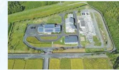
▲宮里浄化センター
