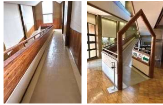
▲スロープ入口 (1階)
