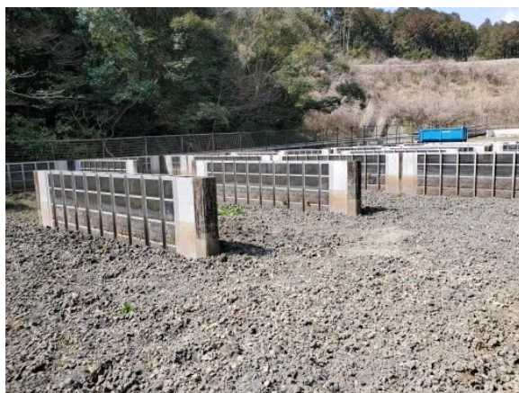
丸山浄水場 天日乾燥床 浄水汚泥の状況
