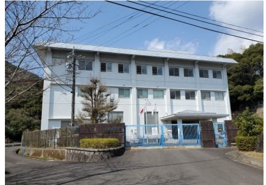
川内地域丸山浄水場管理棟
