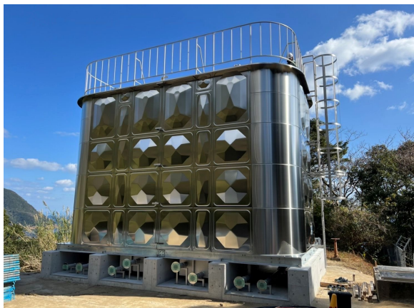
長浜配水池更新工事
