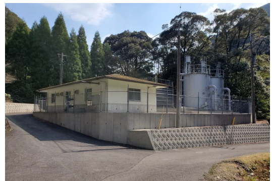
東郷地域中津俣浄水場
