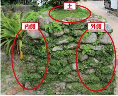
山から採ってきた石を積み上げた石垣が特徴です。外側と内側から積み上げた土を詰めて生垣を植えている2層構造になっています。
