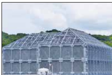
【屋外タンク竜巻防護対策】
