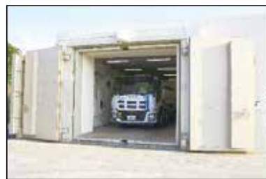
【タンクローリ車庫】
