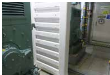
【耐火隔壁の設置】
