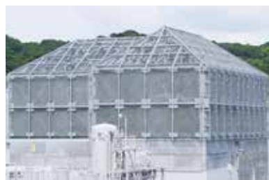
【屋外タンク竜巻防護対策】
