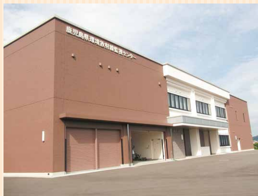
環境放射線監視センター
