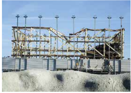
◀ 廃炉に向けたカシキの撤去が開始された1号機原子炉建屋
