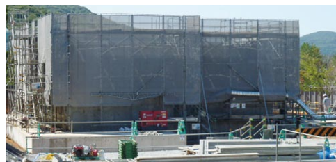
緊急時対策所設置工事状況（平成25年9月末完成予定）
