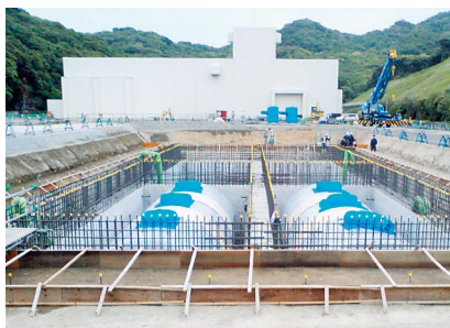
非常用ディーゼル発電機を連続7日間運転できるように燃料油貯蔵タンクを増設
