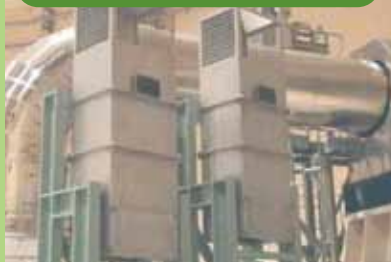
触媒式水素再結合装置5基
