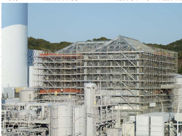
▼復水タンク・燃料取替用水タンクエリア防護対策工事の実施状況
