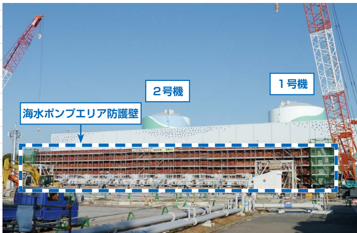
▼海水ポンプエリア防水対策工事の実施状況
