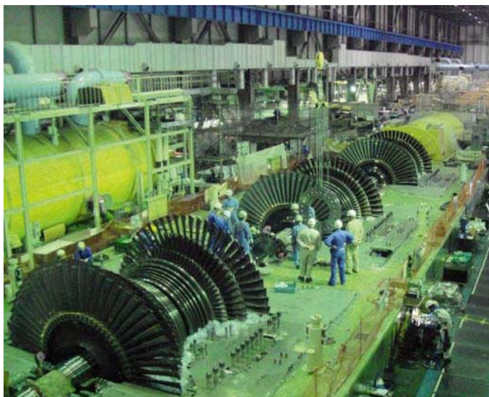
川内原子力発電所2号機 低圧タービン取替 (第19回定期検査)
