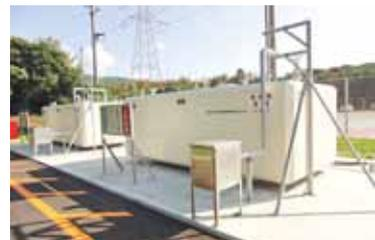
移動式大容量発電機の保管場所近傍に燃料タンクを設置。
