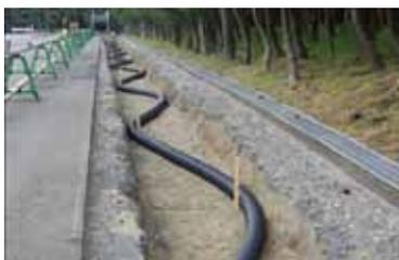
地震による地面の変形等を考慮して、ケーブル長に余裕を持たせて布設しています。
