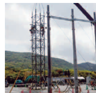
仮鉄柱組立・据付
