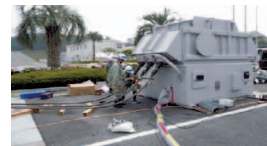
移動用変圧器の接続
