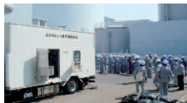
高圧発電機車の繋ぎ込み
