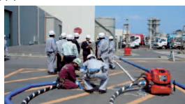
仮設ポンプ設置
