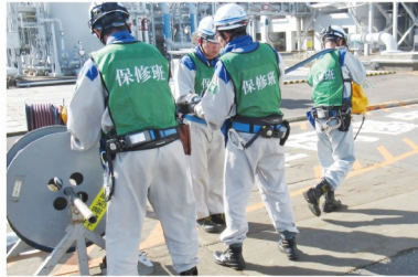
仮設ケーブルの敷設の様子
