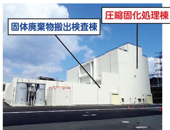
【廃棄物搬出設備の外観】
