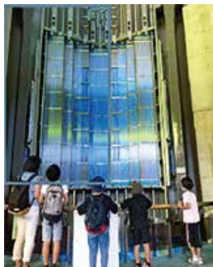
（川内原子力発電所）
