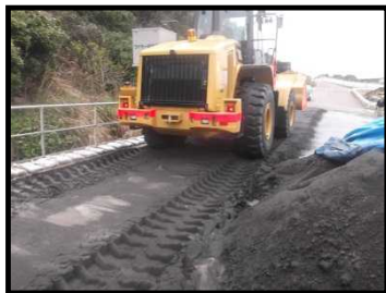
除灰前のホイールローダーの走行試験
