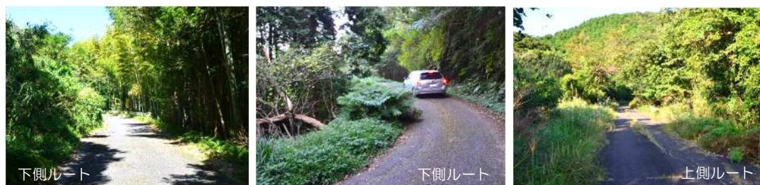
写真 2-22 路線両側の植生が繁茂した既存道路
