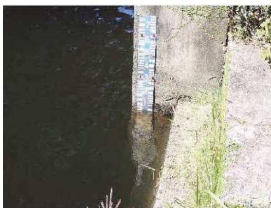
水門の量水板（0 点高標高=296.064m）
