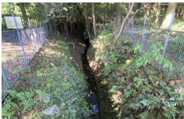
写真 2-4 蘭牟田池水路
