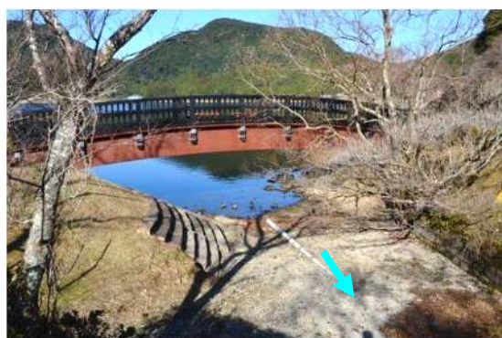
適正水位時の洪水吐入口と蘭牟田池水位状況と水位計 (撮影日：R6.01.17、水位 52 cm)
