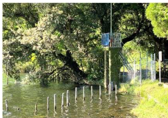
既存の取水樋門
