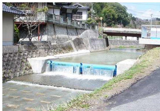
水位調整施設（転倒堰）の事例
