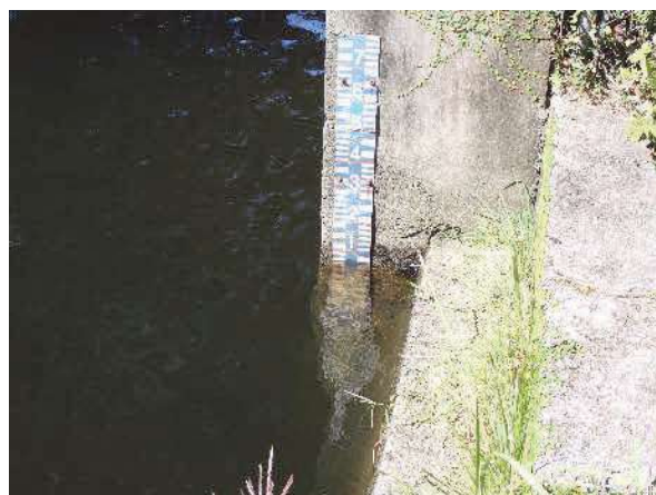
水門の量水板（0点高標高=296.064m）
