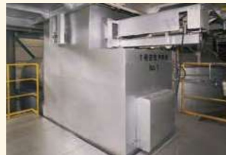
4 空気予熱器No.1 ごみの燃焼を良くするために、排ガスを利用して燃焼用空気を温めます。
