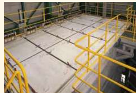
5 集じん装置 排ガス中の有害物質を捕集し、排ガスを清浄にします。また、触媒フィルタを採用することで、触媒作用により排ガス中のダイオキシン類を分解します。
