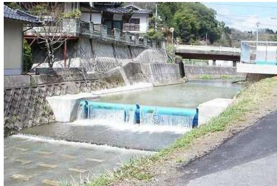
水位調整施設（転倒堰）の事例
