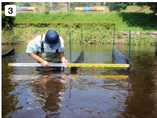
▲ 簡易漁礁の幅（約90cm） 三角網の幅に合わせて簡易漁礁の幅を調節します。
