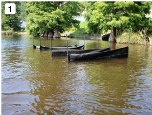
▲ 簡易漁礁は流れが緩やかで、水深0.5～1.0mの場所に設置します。
