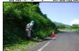
道路除草・管理
