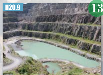
H20.9 県が川永野地区を産業廃棄物管理型最終処分場整備地に決定
