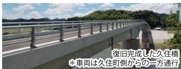
復旧完成した久住橋 *車両は久住町側からの一方通行
