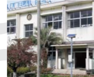
上手小学校に設置された防犯灯
