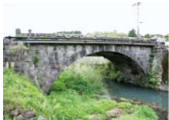
41 上湯田橋(湯田) 湯田川に架かる大正8年に架設された石橋。橋長12.6m・幅員3.3m。湯ノ元踏切右折。
