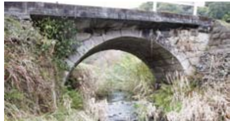
39 西川内橋(田海) 西川内川に架かる石橋。橋長8.25m・幅員3.65m。市道別府原西川内線三文字バス停を右折し約1km。(架設年代不明)
