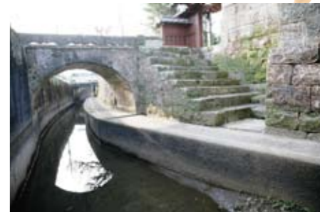
24 みぞはた木原橋(隈之城) 隈之城交差点近くの溝端川に架かる石橋。橋長3.2m・幅員2.12m。(架設年代不明)
