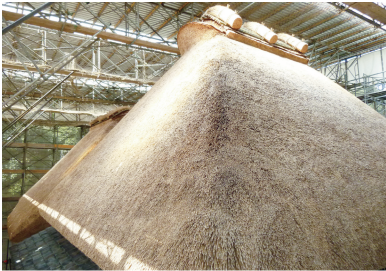
修理が進む旧増田家住宅
