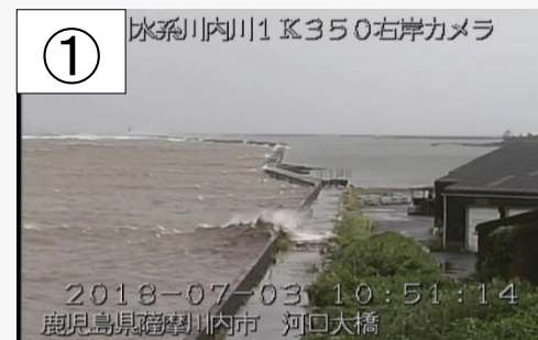
H30.7.3台風7号時 高潮による 越波状況 (船間島地区)
