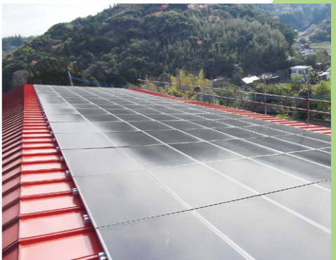
▲西方地区コミュニティセンター太陽光パネル設置後の様子
