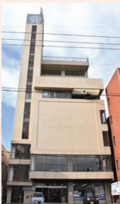
事務所(向田本町・がらっば堂ビル内)
