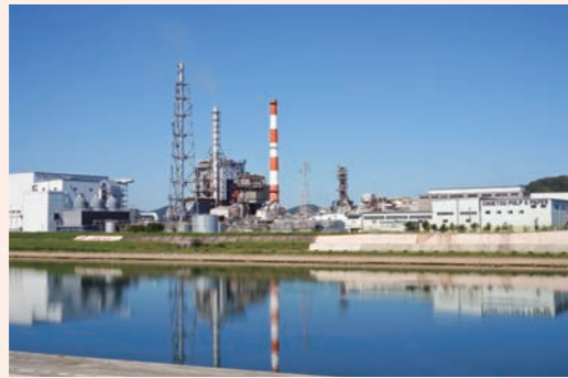
川内工場(全景)
