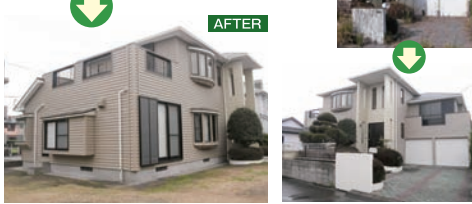
外壁樹脂サイディング貼り工事 外構改修工事
