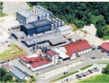
鹿児島工場全景
