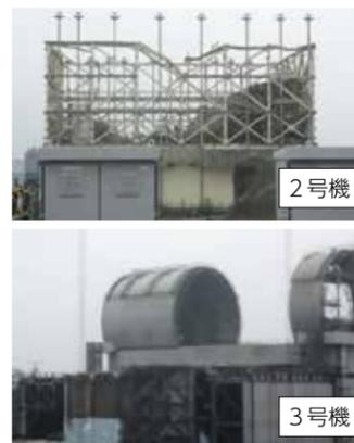
通常、原子力発電に使われた燃料からは高温の熱が発生するため、運転停止後に原子炉内の水を循環させるなどして冷却しています。福島第一原子力発電所では、地震と津波によって、こうした冷却に必要な電源と機能が失われたことから、燃料が溶融。さらに、発生した水素が建屋内に充満して水素爆発が起きました。これにより、原子炉建屋などが破損し、放射性物質が大気中に放出されました。
