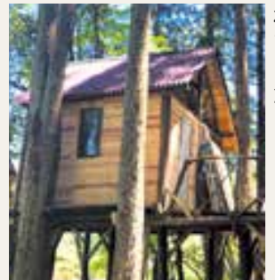
▲ 豊かな森の活動拠点に。建設中のツリーハウス
