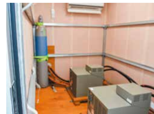
▲微弱な電波をキャッチするためには、とにかく静かにしないとイケないんだって。この超低温を発生させる装置で冷やすことで静かに電波をキャッチすることができるとのこと。写真がボケているのは、超低温のこの部屋のせい？
