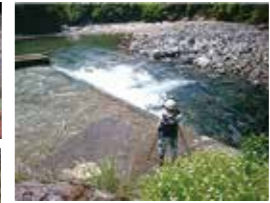
▲レーザ計測の作業風景
