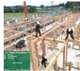
▲組み立て作業の様子
