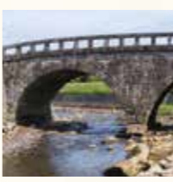
阿蘇鉄矢が肥後の石工・岩永三三郎と手掛けた事跡で市内で唯一残存する「江之口橋」(嘉永2年(1849年)架橋 高江町)
